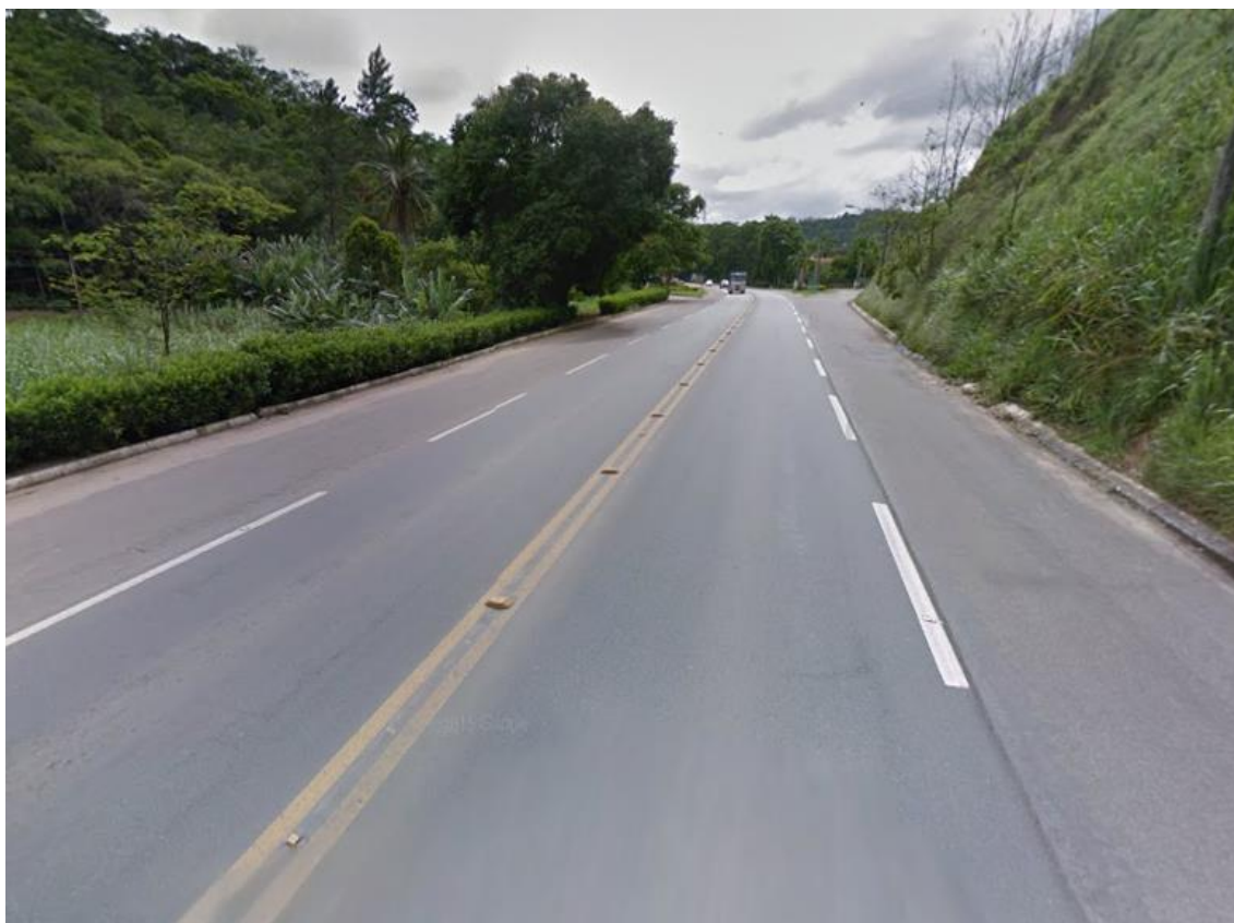
Figura 33. Trecho da BR-101 em pista simples nas proximidades do entroncamento com a ES-257 em Ibirajú
