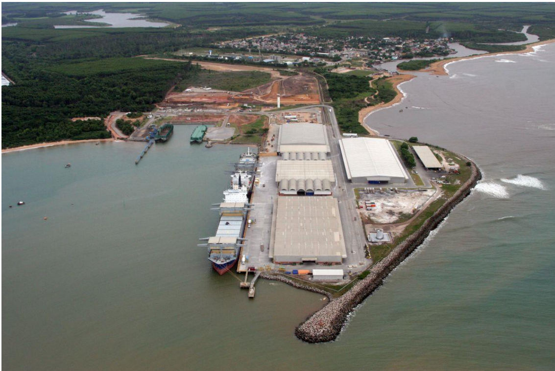
Figura 14. Infraestrutura de acostagem – Portocel
