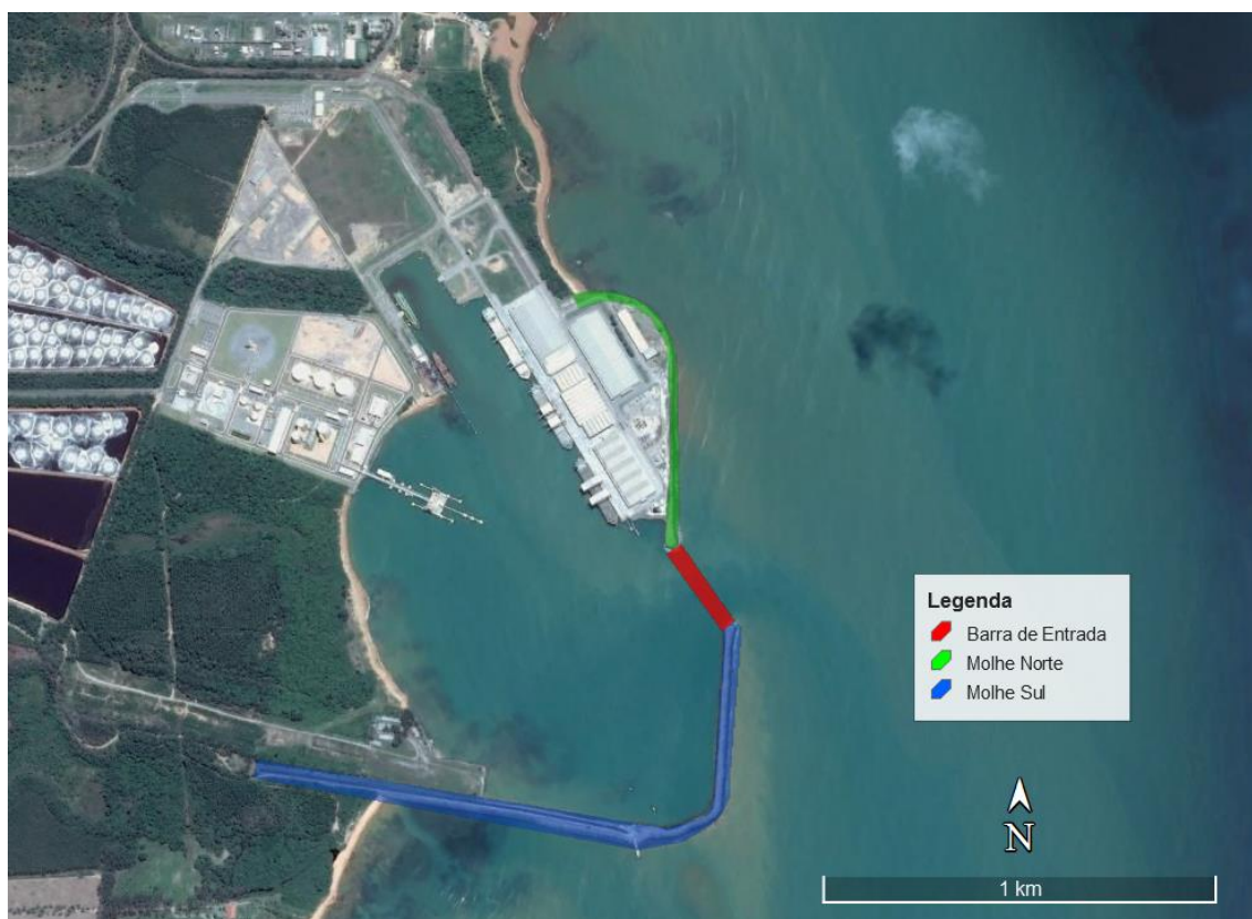
Figura 50. Identificação da barra de acesso ao Porto de Barra do Riacho entre os molhes norte e sul
