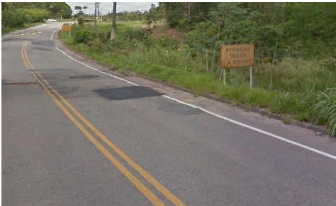
Figura 35. Trecho da ES-010 nas proximidades do entroncamento com a ES-257 em Barra do Riacho
