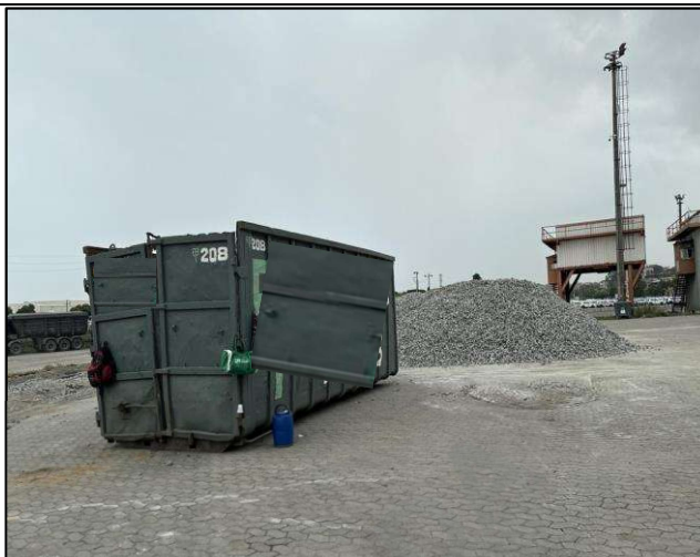
Figura 30: Resíduos de construção civil armazenados em caçamba roll-on
