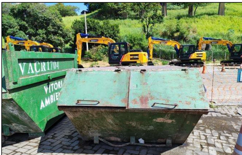
Figura 14: Caçamba de acondicionamento de resíduos de carga com tampa.
