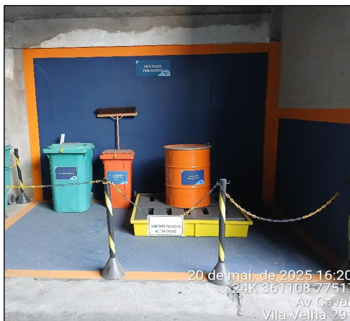
Figura 26: Depósito Intermediário de Resíduos Perigosos Fonte: Acervo Vports (2025)
