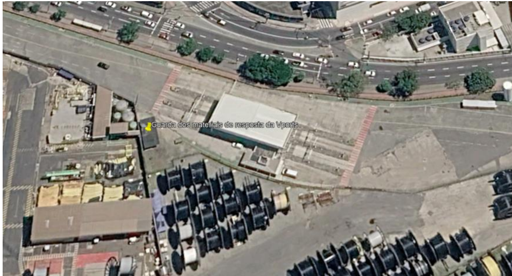
Figura 6 - Localização dos materiais no Cais Comercial de Vitória.
